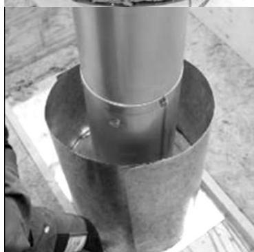
8. Обогните цилиндр (деталь 10) вокруг волоконной теплоизоляции.
