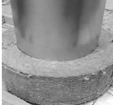
7. Один раз обмотайте дымовую трубу керамоволоконной теплоизоляцией (деталь 5). Минимальная высота – 20 см, а минимальная толщина – 5 см. **Внимание: соединение частей дымохода не должно располагаться внутри керамоволоконной изоляции.**
