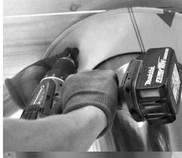
6. Прикрепите кольцо к потолку с помощью винтов (4 шт.), находящихся в коробке для монтажных элементов. Снимите защитную пленку с кольца.
