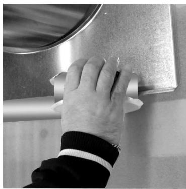
5. Используйте ленту, чтобы плотно прикрепить пароизоляционную пластину (деталь 4). Между пароизоляционной пластиной и дымовой трубой должен быть зазор 2 мм, который затем должен быть закрыт лентой.
