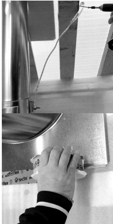
9. Установите вторую секцию метровой дымовой трубы (деталь 2) и затяните соединение с помощью хомута (деталь 6). Закрепите монтажную ленту на хомуте и прикрепите к стропилам с помощью винтов.
